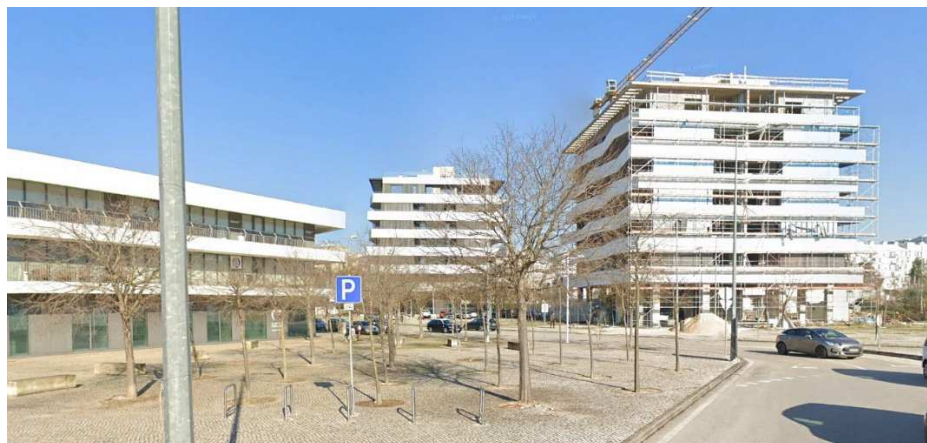
Fig. 5- Tipologias existentes recém-construídas e em construção
