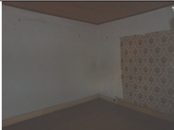
VISTA DA SALA COMUM
