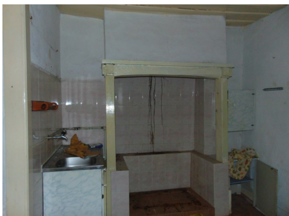
VISTA DA COZINHA
