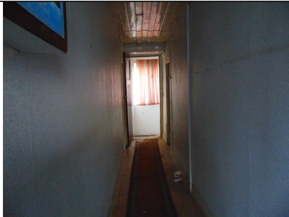
VISTA DA ÁREA DE CIRCULAÇÃO
