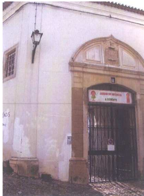
Figura 50 | Localização e imagem da Casa dos Sás Fonte: Parque EXPO e CML (fichas de levantamento do património), 2011
