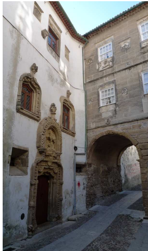
Figura 43 | Localização e imagem do Paço de Sub-Ripas Fonte: Parque EXPO, 2011
