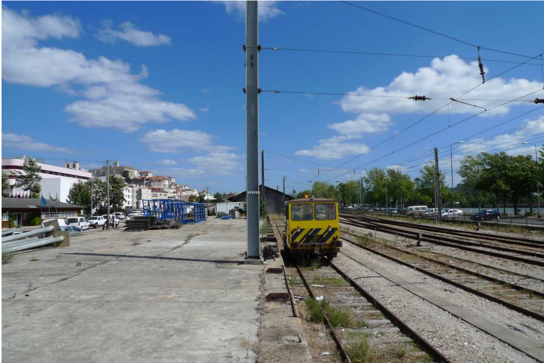
Figura 766 | Linha de caminho-de-ferro – ligação entre Coimbra-A e Coimbra-B Fonte: Parque EXPO, 2011
