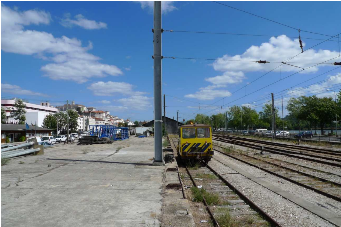
Figura 62 | Linha de caminho-de-ferro – ligação entre Coimbra-A e Coimbra-B Fonte: Parque EXPO, 2011
