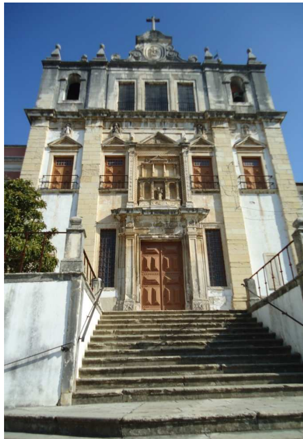
Figura 45 | Localização e imagem da Igreja de Santa Justa Fonte: ParqueEXPO,2012.
