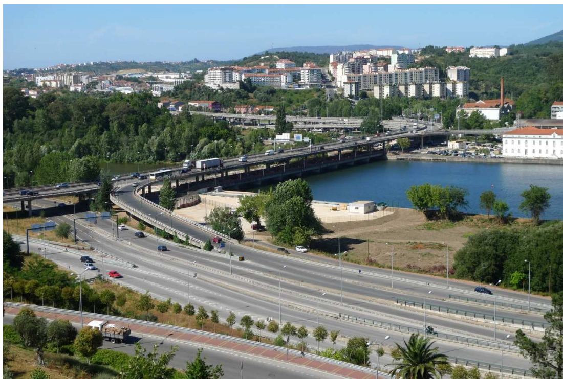
Figura 12 | Coimbra, Ponte do Açude Fonte: Parque EXPO, 2011
